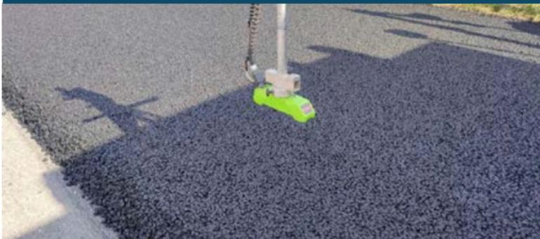
**SMA (Stone Mastic Asphalt) namijenjen je za izradu habajućeg sloja asfalta, a ugrađuje se u tehnološkoj debljini koja zavisi o veličini zrna.**
